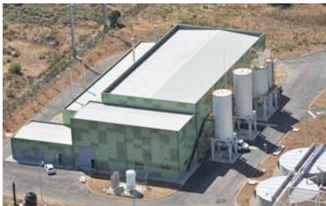
Edifício de Desidratação, Cogeração e Secagem Térmica.
