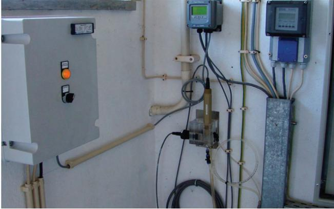
Foto 8.2.1.4.2 – Melhoria no sistema de controlo de desinfectante no reservatório de Alter do Chão
