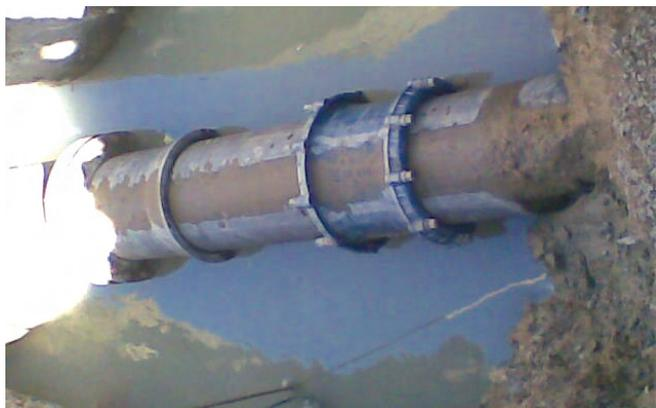
Foto 8.2.1.7.4 – Intervenção realizada na conduta de adução aos municípios de Crato e Alter; FFD DN400
