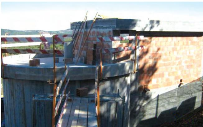
Fotografia 8.3.2.1.2.3 – Construção do Reservatório de Nave Fria e Respectivas Ligações
