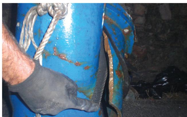
Fotos 8.2.1.7.3 – Substituição de filtro na conduta de abastecimento aos principais reservatórios de Portalegre
