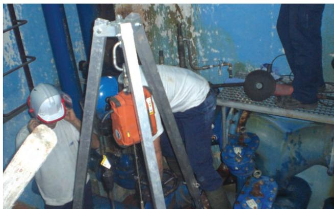
Foto 8.2.1.7.2 – Intervenção realizada no Miradouro - substituição de uma junta
