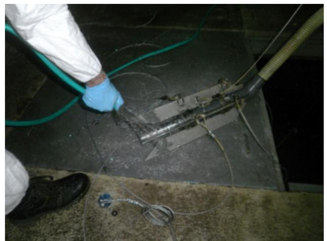
Manutenção regular da sonda espectrofotométrica S:CAN
